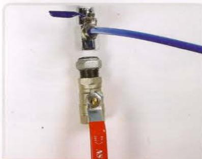
**1** Проверка герметичности соединений
